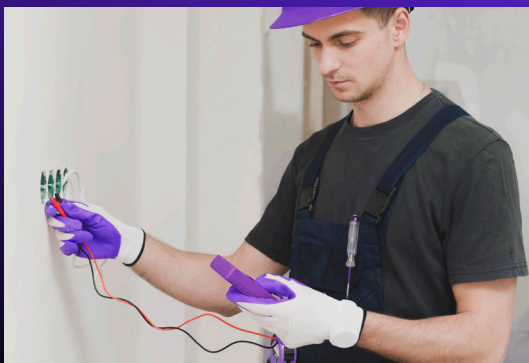
Testování elektrických rozvodů
